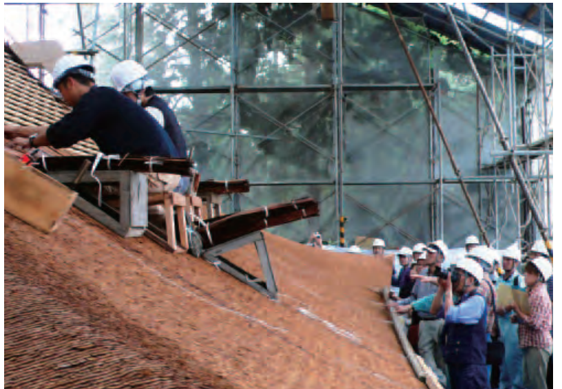
職人が竹釘で檜皮を一枚ずつ留めていく様子を見学（園城寺大門）
