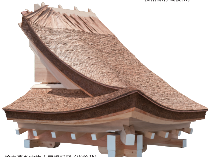
檜皮葺き実物大屋根模型（当館蔵）
